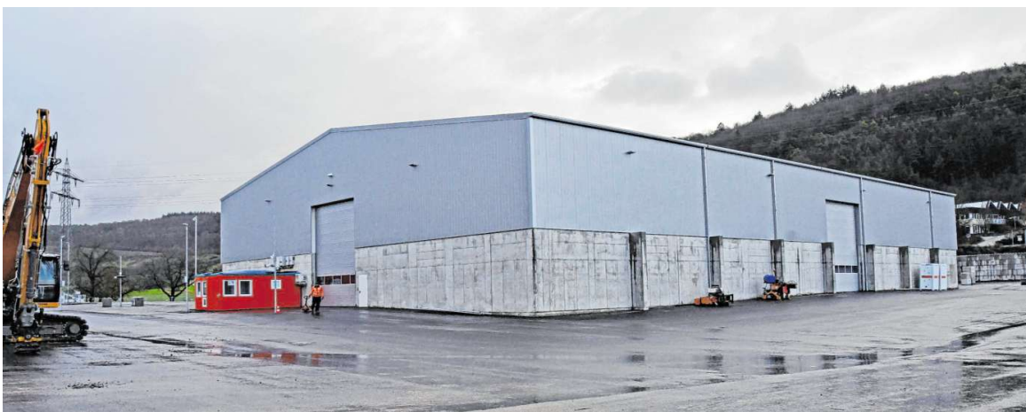
Die baurechtliche Abnahme der Bodenverbesserungsanlage der Firma Konrad Bau im Gerlachsheimer Gewerbegebiet „Pfitzenacker“ ist durch das Landratsamt Main-Tauber-Kreis erfolgt.
