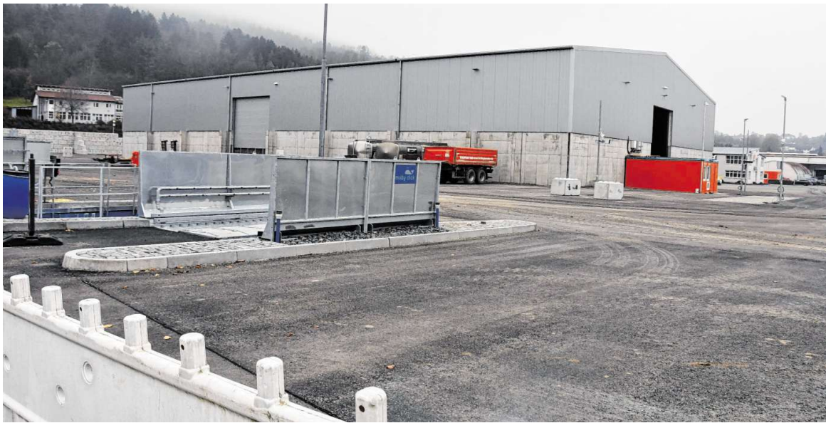
Fast fertig ist der Bau der Bodenaufbereitungsanlage der Gerlachheimer Firma Konrad Bau im Gewerbegebiet „Pflützenacker“. Der Probebetrieb ist aber noch nicht gestartet.
